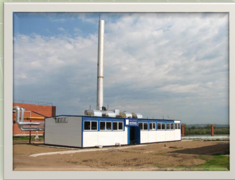
ООО «Коммусервис» Реконструкция объектов и сетей теплоснабжения
