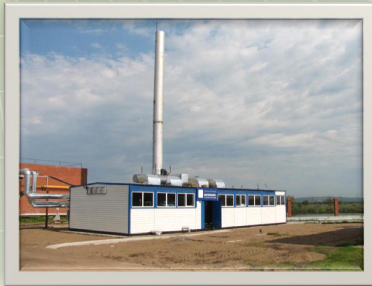
ООО «Коммунсервис» Реконструкция объектов и сетей теплоснабжения
